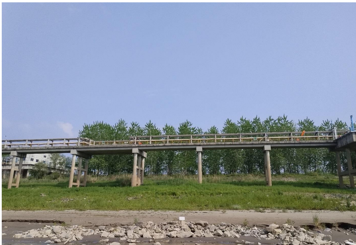
图 2.2.2-8 码头靠岸一侧的情况
